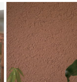
▲ご主人施工のこだわり左官壁
