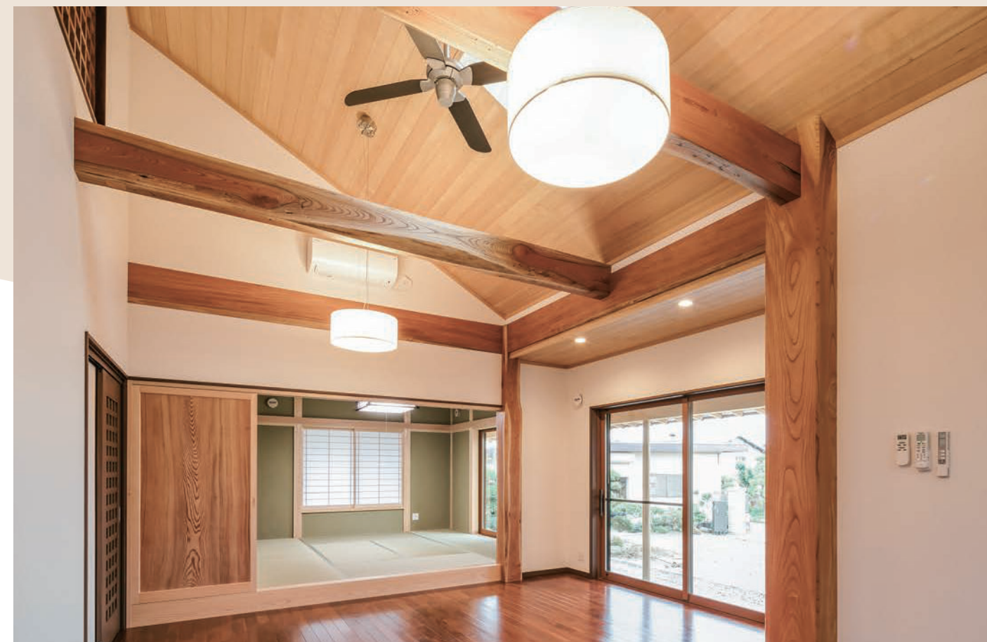
和室側の一枚板の扉は木目の凹凸が強調される美しい加工技法「浮造り」
